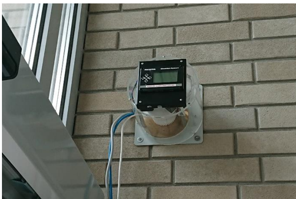
Óramű és 2058 vezérlő a fal belső oldalán
