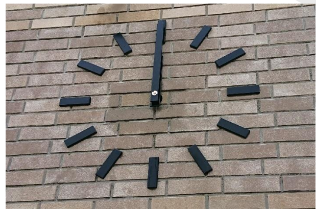
Óramutatók, a „számlap” 100cm-es átmérőjű
